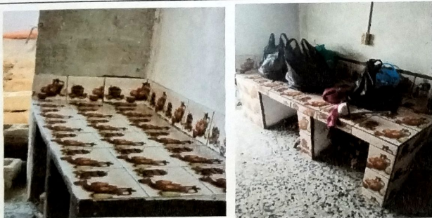
Foto 3: Vista de bases de concreto con aplicacion de azulejo .
